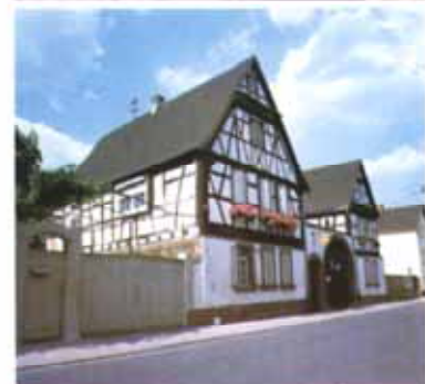
Aufgesetzter Rolladenkasten an der Traufseite stört das gute Gesamtbild des stattlichen Anwesens
